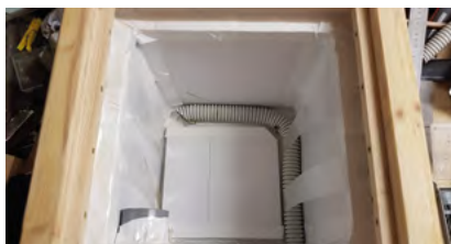
Zateplený čmelín s vyústěním větrací pasti
